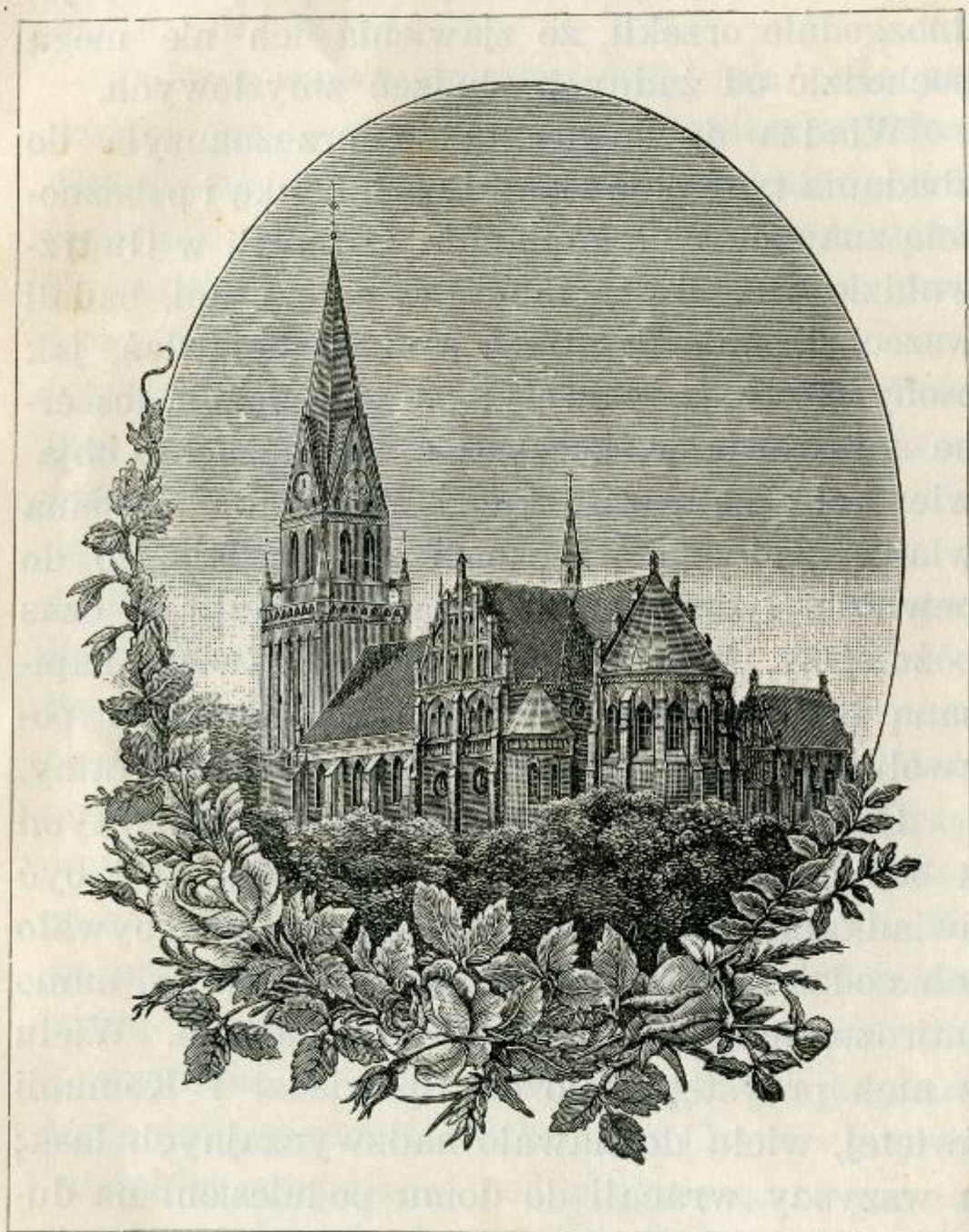
Widok nowego kościoła w Gietrzwałdzie.
